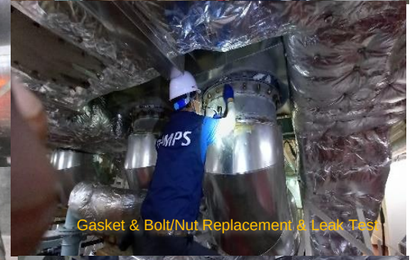
LNGC MGE Gas Pipe Leakage Repair
